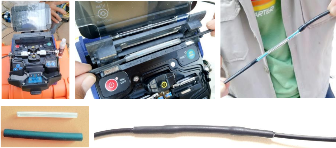
ภาพประกอบที่ 5. เชื่อมต่อ OFTK กับสาย Round Type 1F ด้วยวิธี Fusion Splicer ท่อหุ้มด้วยท่อหด
