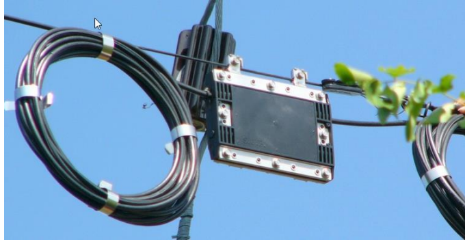
ภาพประกอบที่ 11. หัวต่อสาย OFC Drop-wire 12F นำมาเชื่อมต่อสาย OFC Round Type 2F
