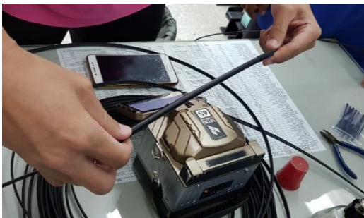
ภาพประกอบที่ 8. หุ้มจุดเชื่อมต่อสาย OFC Round Type 2F ที่ใช้ท่อ Protection Sleeve ร่วมกัน 2 เส้นด้วยอุปกรณ์ Pre-Heat Shrinkable Tube
