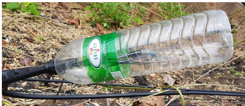
ภาพประกอบที่ 10. สวมจุดเชื่อมต่อสาย OFC ด้วยขวดน้ำดื่ม
